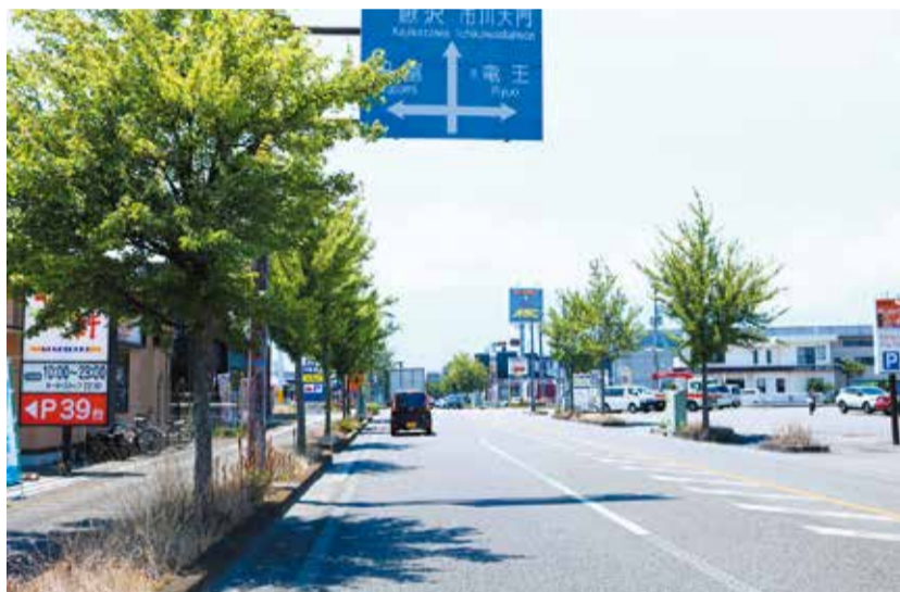
無電柱化された昭和通り(飯喰東の交差点から)
