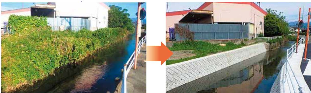
鎌田川護岸工事前と後(2023年5月末、昭和町西条地区)
